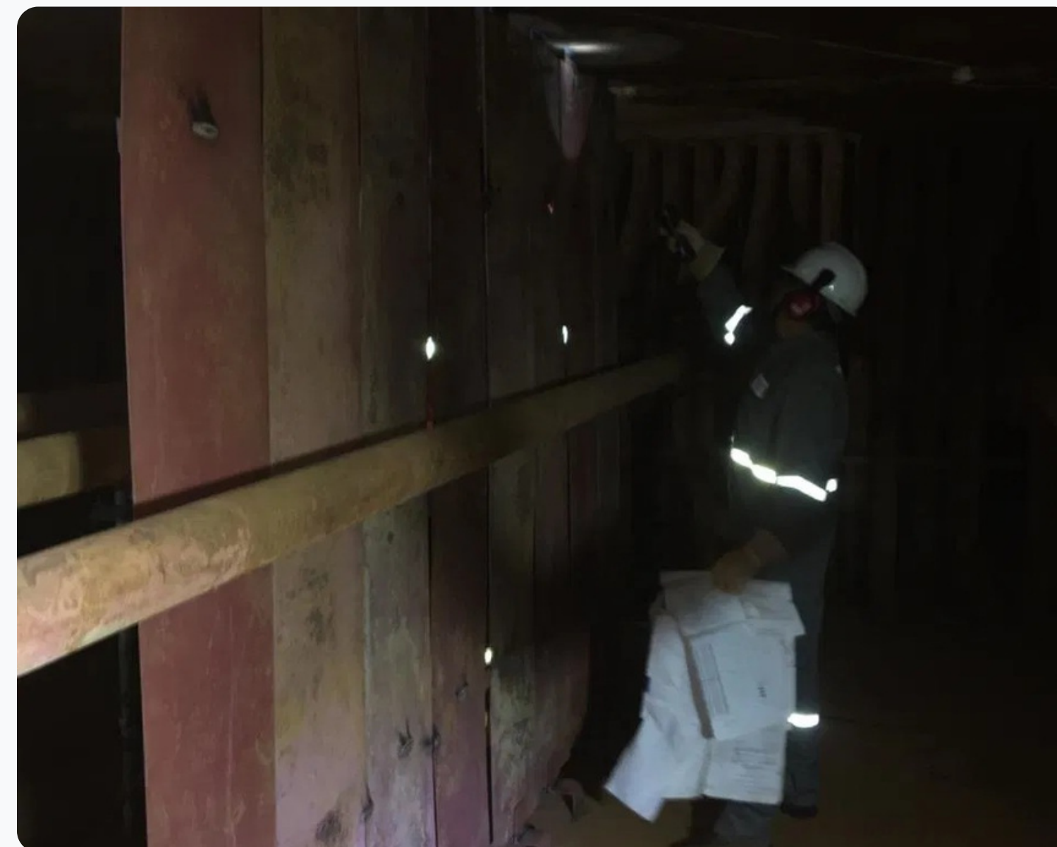
Inspeção técnica em ambientes confinados
